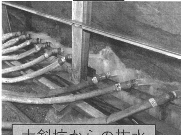
大斜坑からの抜水
