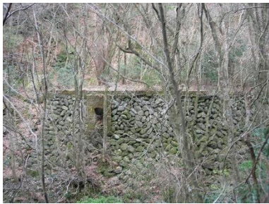
東平のペルトン水車設置跡地
