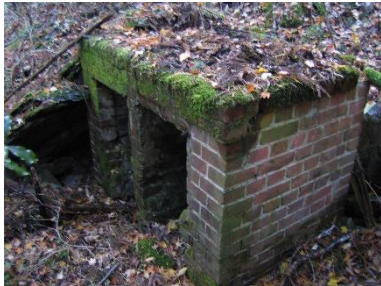
黒橋に残る厨房設備
