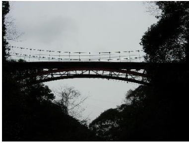
落シ橋（遠登志橋）
