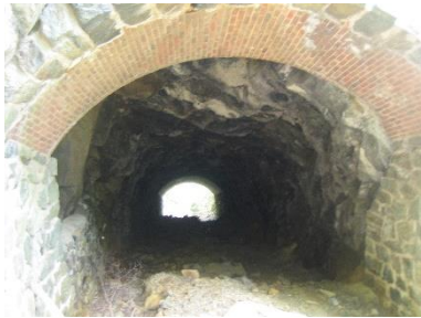
東端索道のセリ割隧道
