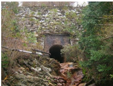
東延谷築堤と暗渠
