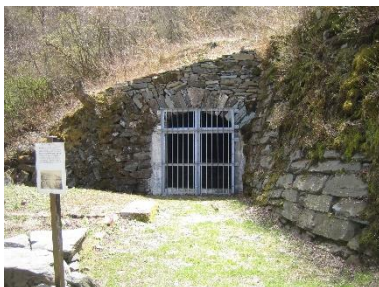
第一通洞（北口）
