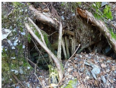
小足谷疏水坑
