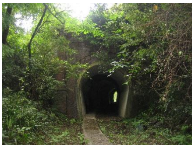
下部鉄道の車屋隧道
