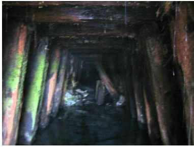
坑口の隙間から写した第二通洞内
