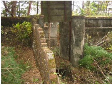
端出場水力発電所用の石ヶ山丈貯水池
