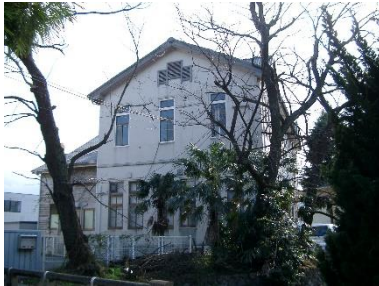
惣開町の旧住友別子病院（解体前）
