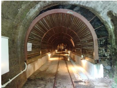
現在、唯一入坑可能な筏津東走坑の内部
