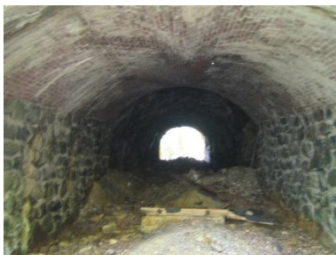
東平の東端索道セリ割隧道内部
