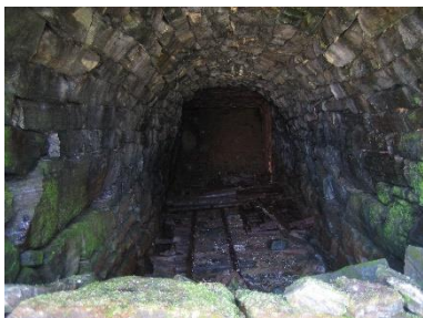
坑口の隙間から写した第一通洞内
