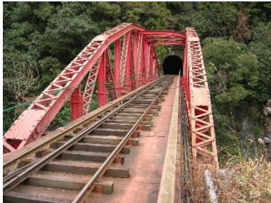
下部鉄道の芦谷川橋（端出場鉄橋）
