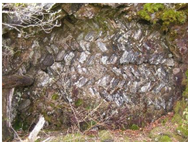
寛永谷最大の坑口である新太平坑
