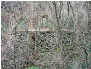
東平・辻坂のペルトン水車設置跡地
