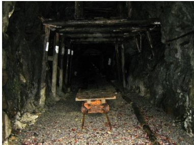
坑口の隙間から見た第三通洞内
