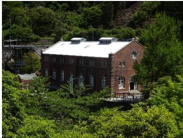
耐震補強された端出場水力発電所
