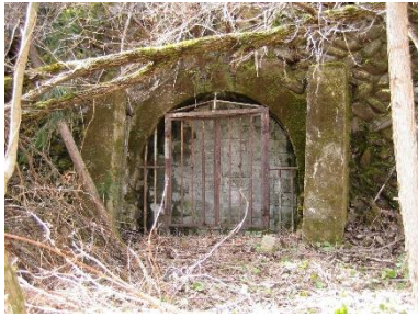
銅山川左岸にある筏津西走坑
