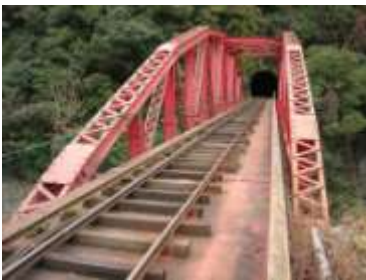
芦谷川橋（端出場鉄橋）
