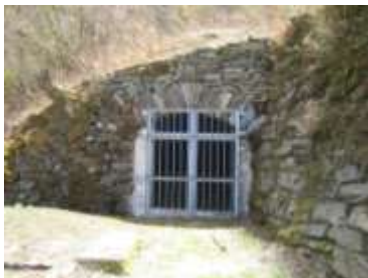
第一通洞（北口）
