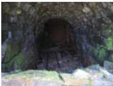
第一通洞内部（北口付近）
